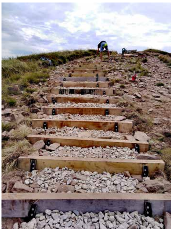
Budowa stopni przeciwieryjnych (fot. R. Sidor).
