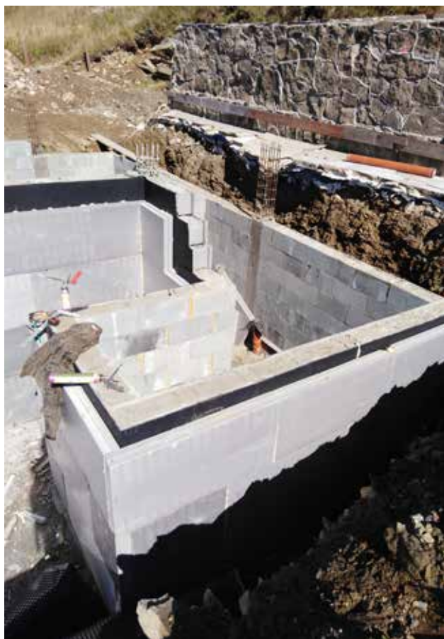
Piwnica budynku schronu turystycznego (fot. M. Żmijewska).
