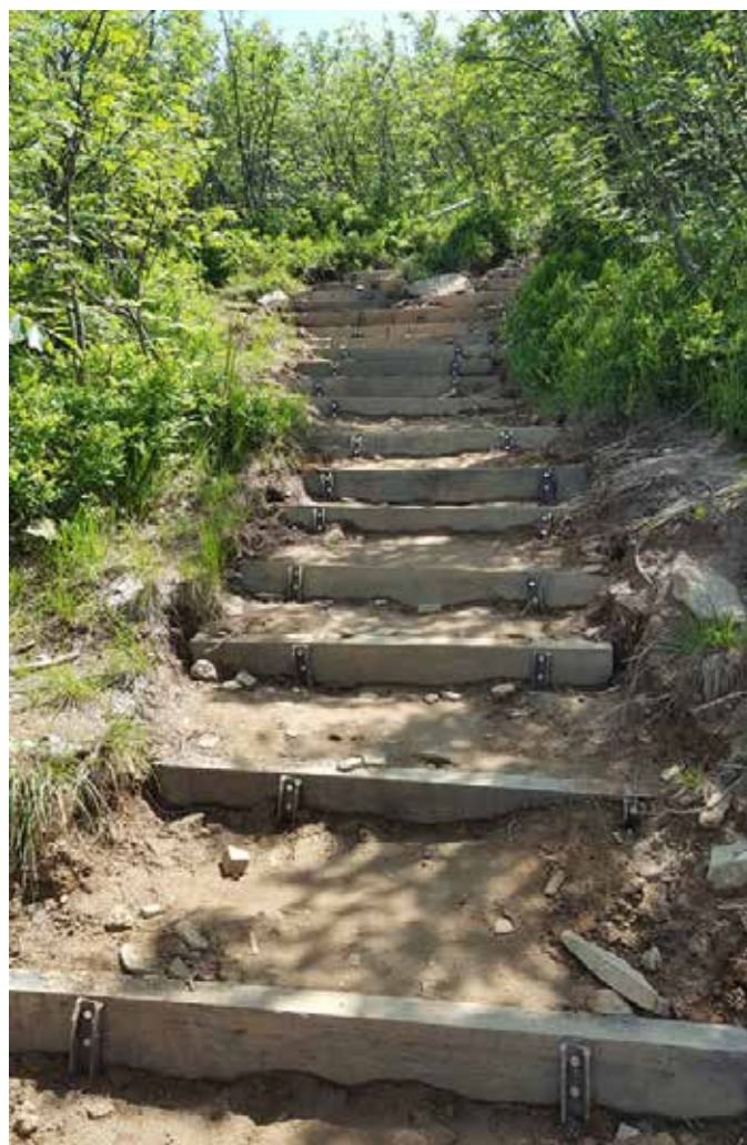
Mała Rawka – rynna erozyjna (fot. R. Sidor) oraz progi przeciwoerozyjne (fot. T. Demko).
