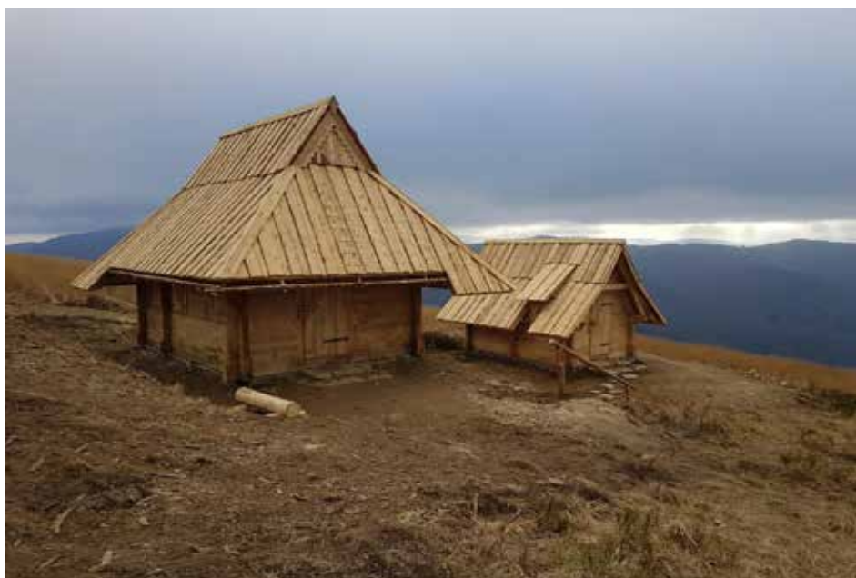
Bacówka w trakcie i po zakończeniu prac budowlanych (fot. W. Pietrasz).
