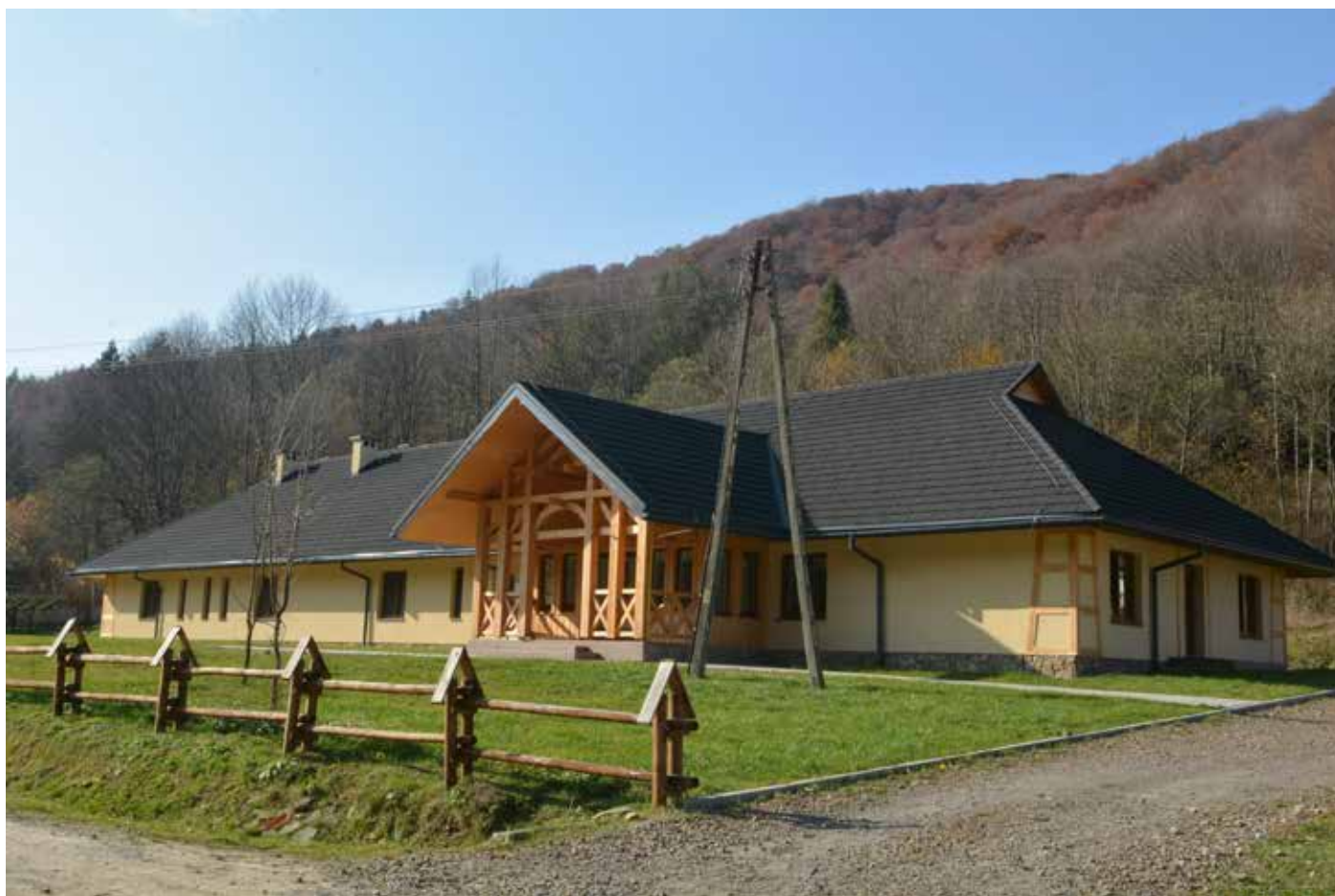
Widok budynku od drogi dojazdowej (fot. G. Holly).
