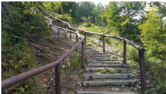
Bariery drewniane (fot. T. Demko).
