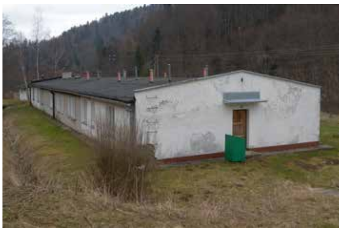
Stan budynku przed rozpoczęciem prac (2011 r., fot. T. Winnicki).
