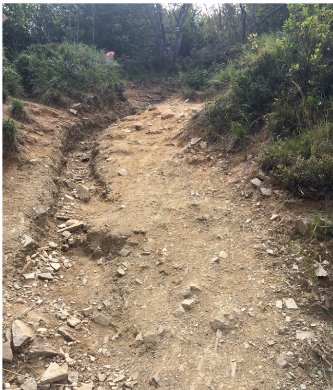
Rywna erozyjna na stromym odcinku szlaku.
