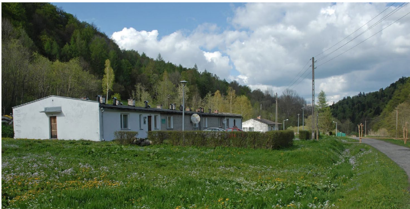
TSEE w Suchych Rzekach przed rozpoczęciem inwestycji.
