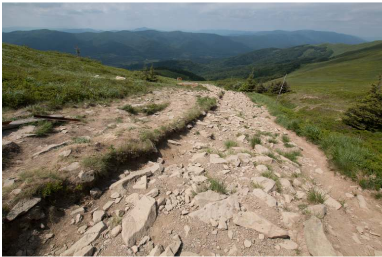
Szlak Wołosate - Tarnica rozdeptany na szerokości 15 m..., powierzchniowe zniszczenia darni, stan sprzed remontu
