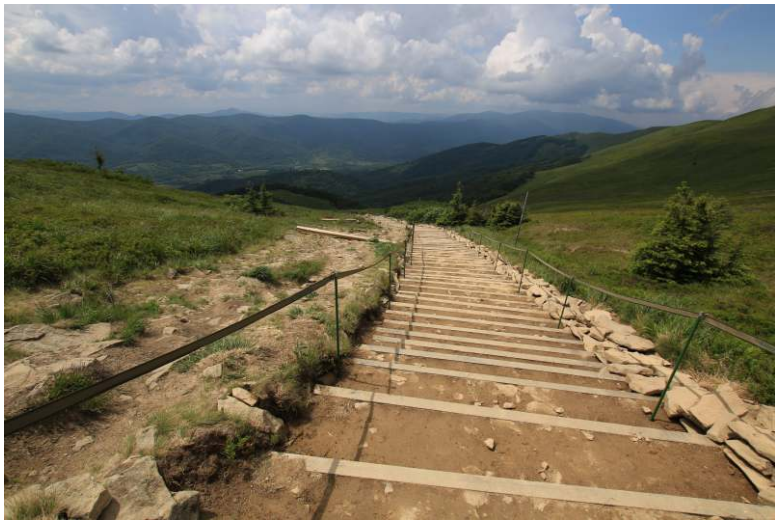
Szlak Wołosate - Tarnica zawężony do 2,5 metra, progi, bariery taśmowe stan pod koniec remontu
