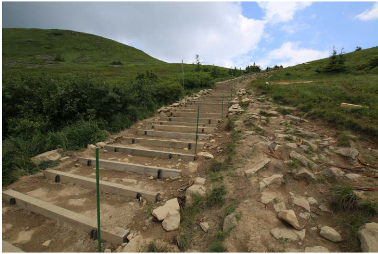
Progi przeciwoerozyjne, bariery taśmowe w trakcie montażu, stan na koniec czerwca
