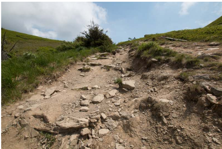
Szlak rozdeptany na szerokości 15 m., zniszczenia darni, stan sprzed remontu
