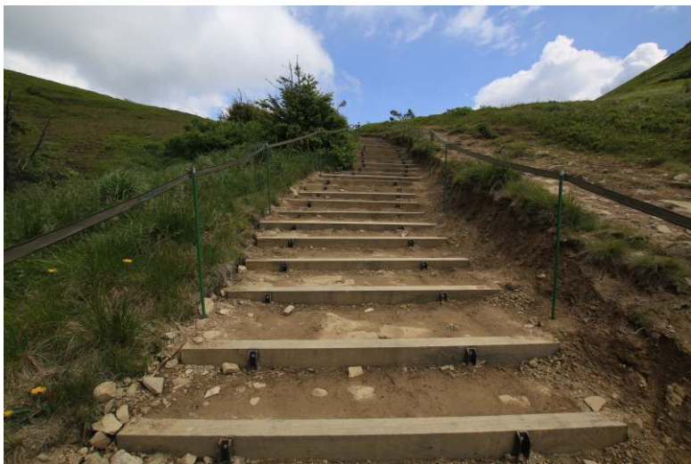
Progi przeciwoerozyjne, bariery taśmowe w trakcie montażu, poza barierami samoistna lub wspomagana regeneracja darni roślinnej
