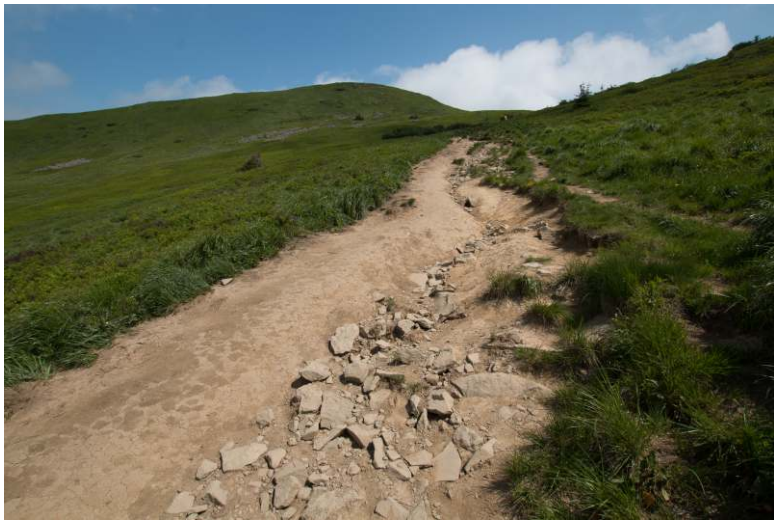
Szlak rozdeptany na szerokości 10 m.,bruzdy erozyjne ruchomy rumosz skalny, stan sprzed remontu
