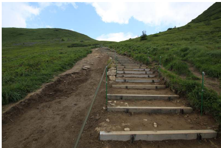
Progi przeciwoerozyjne, zawężenie szlaku do 2,5 m bariera taśmowa 1 m.. wysokości - stan na koniec czerwca, miejsca poza szlakiem przeznaczone do regeneracji darni
