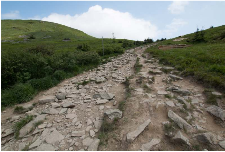
Szlak rozdeptany na szerokości 10 m., zniszczenia darni, stan sprzed remontu
