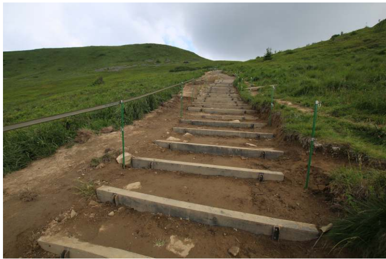
Progi przeciwoerozyjne, zawężenie szlaku do 2,5 m bariera taśmowa 1 m.- stan na koniec czerwca, miejsca poza szlakiem przeznaczone do regeneracji darni
