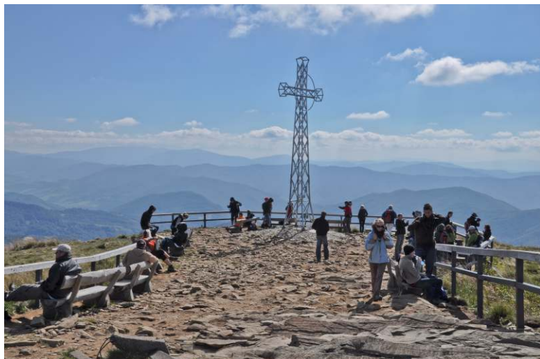
Powstanie platformy widokowej na Tarnicy, 2010 r.
