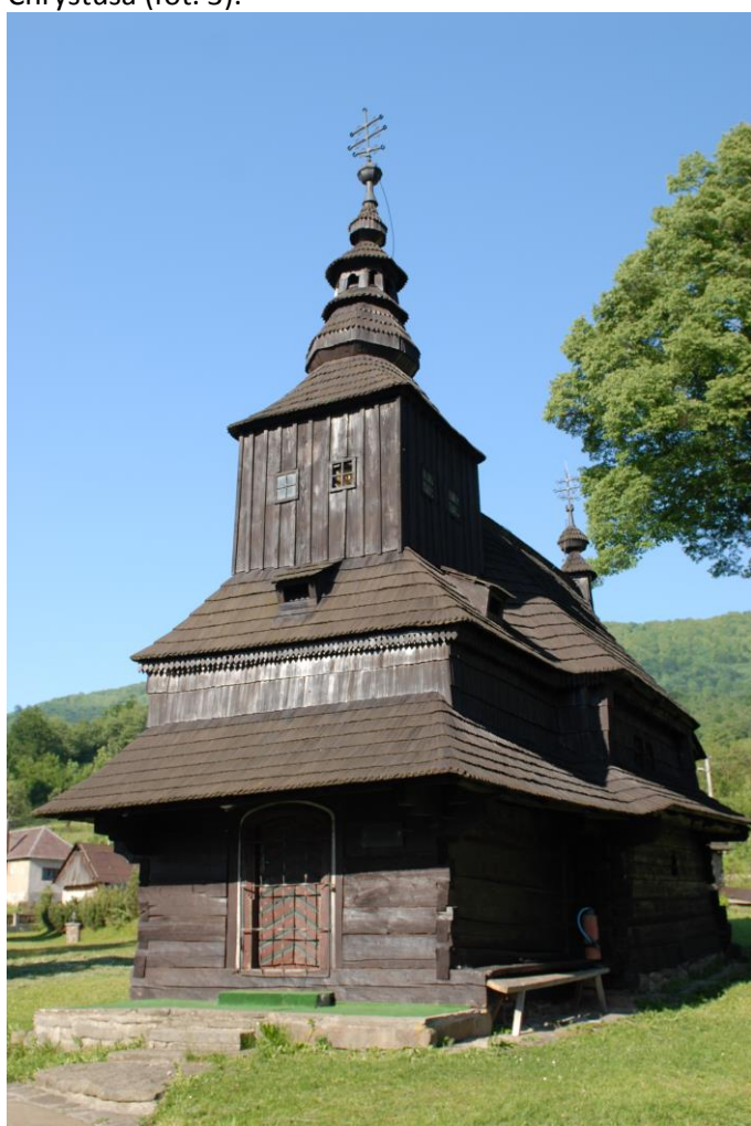
Fot. 1. Rusky Potok - Cerkiew pw. św. Michała Archanioła z 1751 r. (fot. G. Holly).
