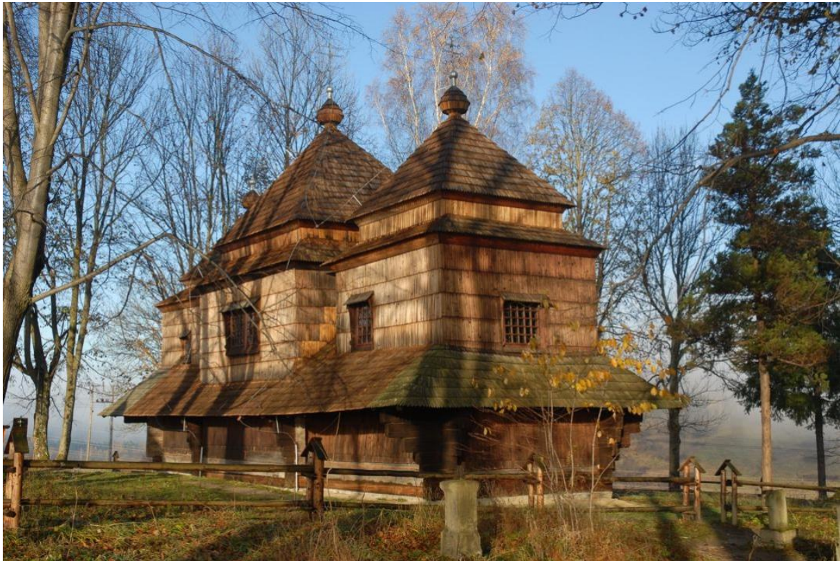
Fot. 1. Smolnik. Dawna cerkiew greckokatolicka pw. św. Michała Archanioła z 1791 r., obecnie kościół rzymskokatolicki pw. Wniebowzięcia NMP (fot. G. Holly).
