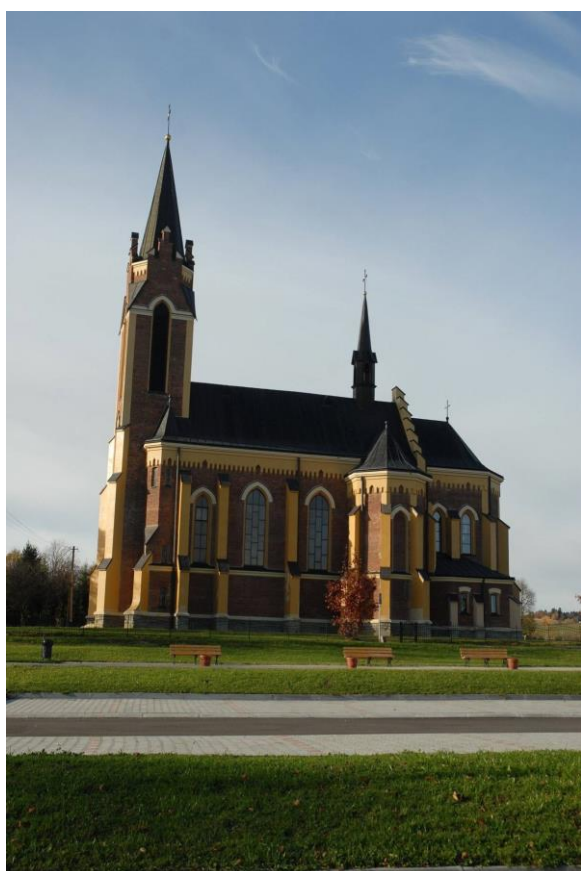
Fot. 1. Lutowiska - widok na kościół od strony południowej (fot. G. Holly).
