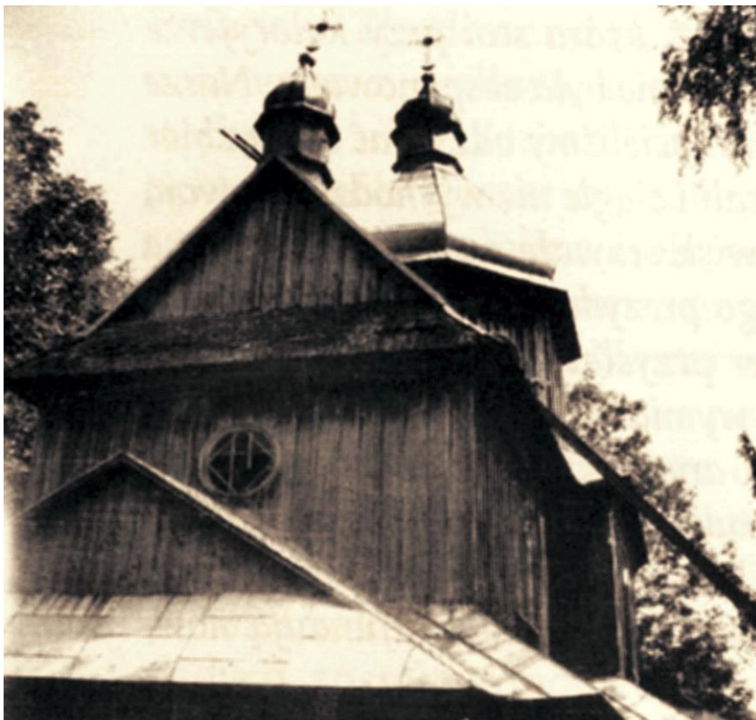
Ryc. 1. Krywka. Cerkiew greckokatolicka z 1901 r. (fot. z ok. 1960 r.), Źródło: Kryciński S. 2005, s. 144.
