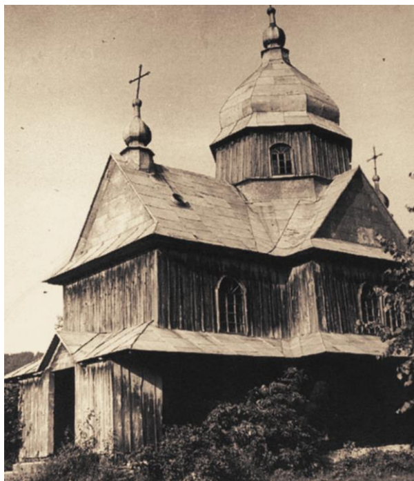
Ryc. 1. Chmiel. Cerkiew greckokatolicka z 1906 r. Fot. R. Brykowski, stan z 1967 r. (Brykowski R. 1995, Brykowski Ryszard , „Drewniana architektura cerkiewna na koronnych ziemiach Rzeczypospolitej, TONZ, Warszawa, s. 205).
