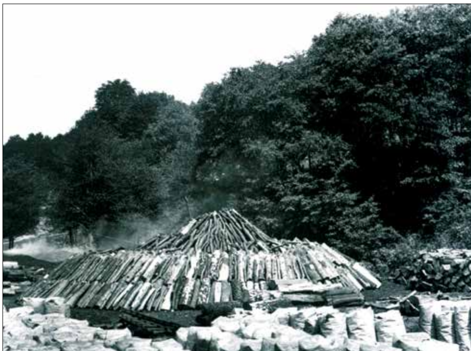
Ryc. 2. Mielerz w trakcie układania przed okryciem oponą – 1978 r. (Fot. E. Miśkowiec). Fig. 2. Earth-mound kiln before covering with earth – 1978 (Phot. E. Miśkowiec).
