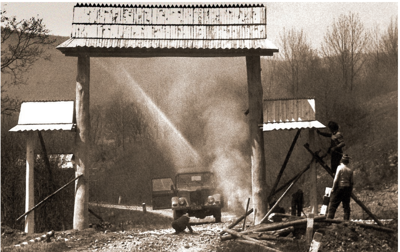
Budowa bramy do BdPN w dolinie Wołosatki, 1978 (arch. BdPN).
